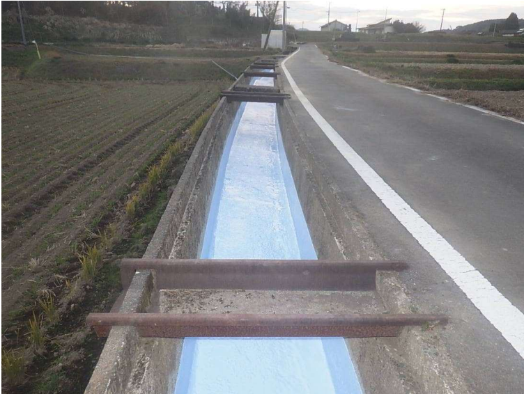
対象物:水路 材 質:コンクリート
