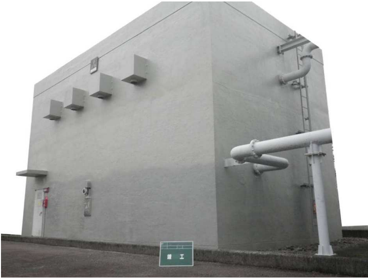
対象物:変電所 材 質:コンクリート
