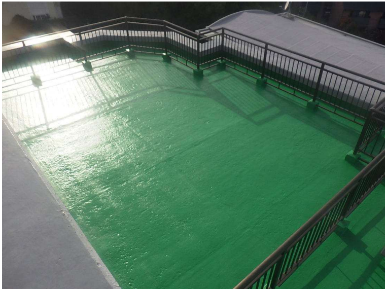
対象物:ルーフバルコニー 材 質:シンダーコンクリート
