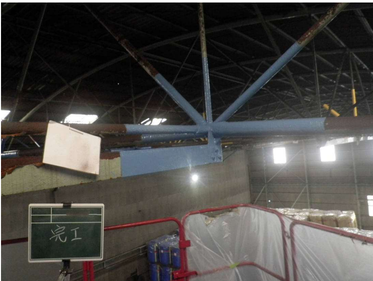
対象物:工場 材 質:屋根骨組(鉄製)
