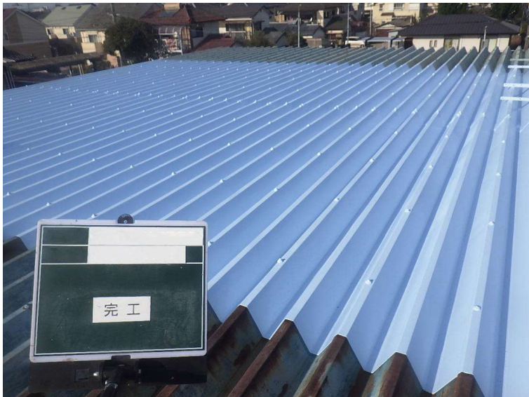
対象物:店舗屋根 材 質:折板屋根(金属)
