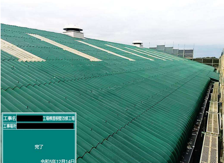
対象物:工場(屋根・壁) 材 質:波板スレート
