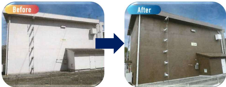
変電所(コンクリート)
