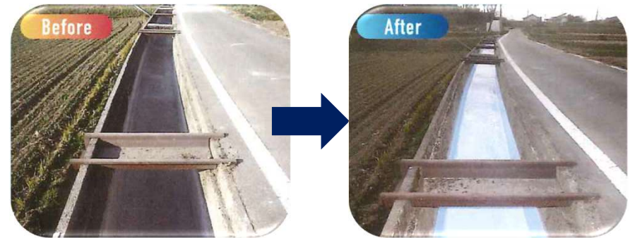
水路(コンクリート)
