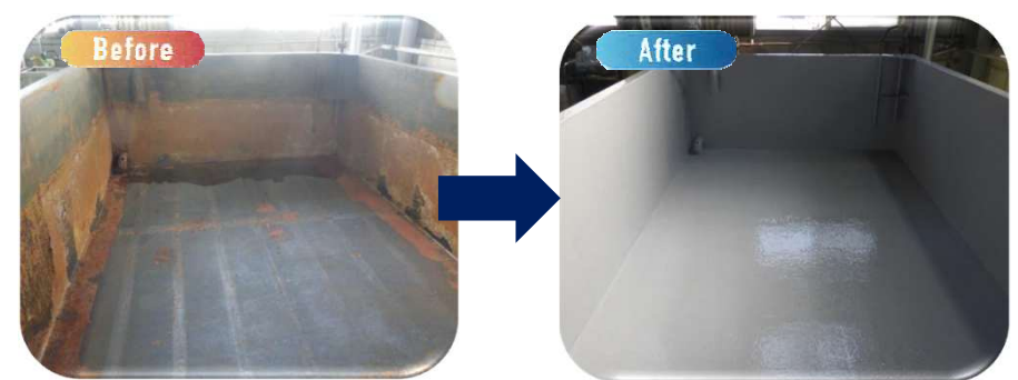
溶解層鉄板(復活パワーコートT)
