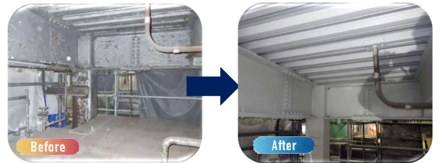
スラブデッキ(復活パワーコートA)
