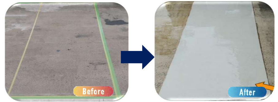
コンクリート床(復活パワーコートT)
