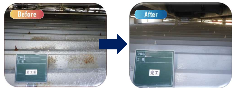
折板屋根(復活パワーコートA)
