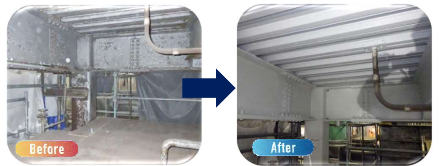
スラブデッキ(復活パワーコートA)
