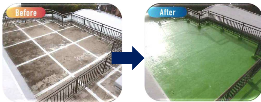
ルーフバルコニー(シンダーコンクリート)
