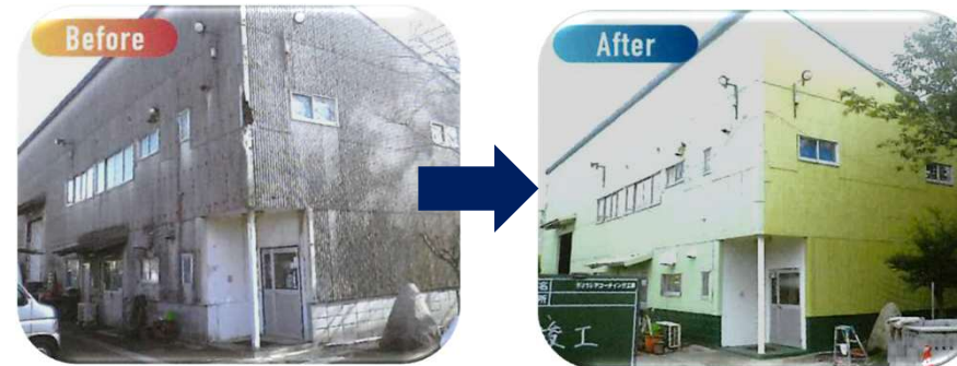
スレート倉庫(事務所)
