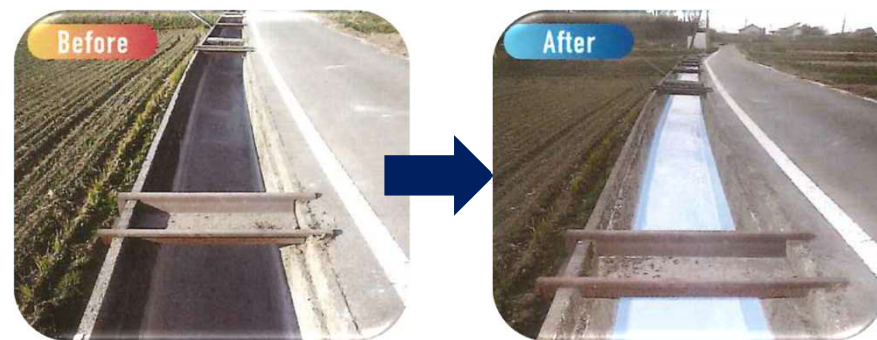
水路(コンクリート)
