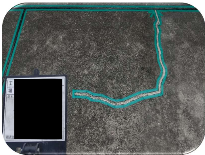
クラック補修シーリング
