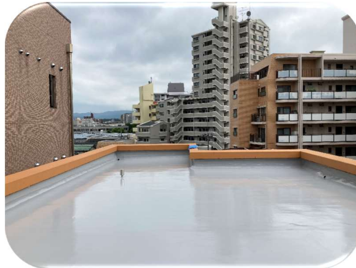
ウレタン塗膜通気緩衝工法
