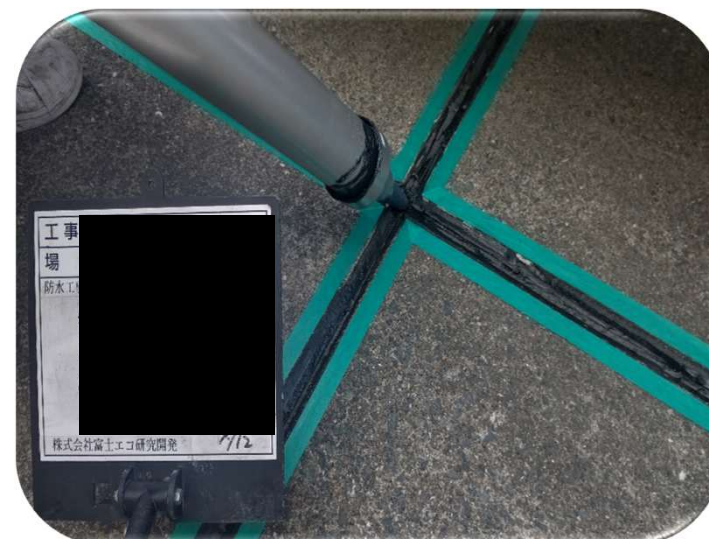
伸縮目地シーリング
